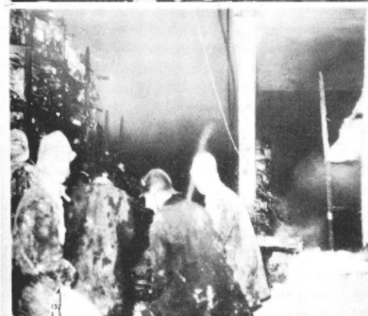
Con sus vidrieras, los bomberos penetraron en el edificio incendiado.
